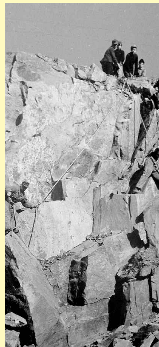
Nach der Sprengung wurde das noch lose sitzende Gestein von den sog. „Ausbrechern“ mit Stemmeisen von der Wand gelöst, damit die Felsbrocken die darunter arbeiteten Leute nicht gefährdeten. An Seilen, die an Bäumen befestigt waren bzw. von Arbeitern gehalten wurden, sicherten sich die „Ausbrecher“ bei ihrer Tätigkeit ab.
