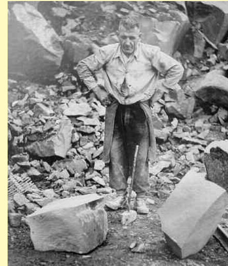
Nach schwerem Schlag mit dem Vorschlaghammer (Schlägel) auf den Keil wird der Gesteinsblock zu „Knüppeln“ zerkleinert.
