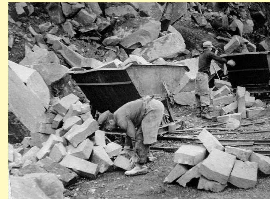
Loren als Transportmittel auf Schmalspurschienen gefüllt mit vorgefertigten Knüppeln auf dem Weg zu den Abrichtern, von da aus mit verarbeiteten Naturwerk- oder Pflastersteinen zur Verladestation, oder beladen mit Gesteinsbrocken für das Brechwerk zur Schotterherstellung. Eine Lore hatte einen Rauminhalt von einem Kubikmeter, was einem Gewicht von 1,4 Tonnen entsprach.
