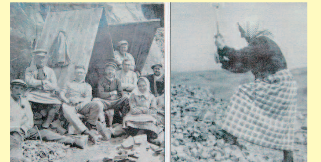
Linkes Bild: Wohlverdiente Ruhepause. Frauen brachten Essenskörbchen vorbei. Rechtes Bild: Steinklopfen („Wackepickerin“) beim Zerschlagen des Hartgesteins zu Schotter. In späterer Zeit übernahm diese Arbeit das Brechwerk.
