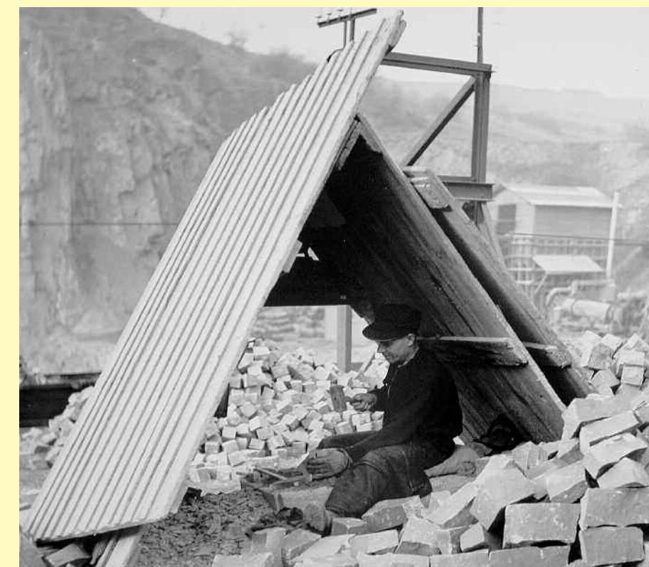
Abrichter schlägt mit dem kleinen Abrichtehammer Knüppel zu Pflastersteinen in vorgegebenen Grösseneinheiten zu. Die „Bille“ auf dem Arbeitstisch wird zum Glätten der Oberflächen eingesetzt.
